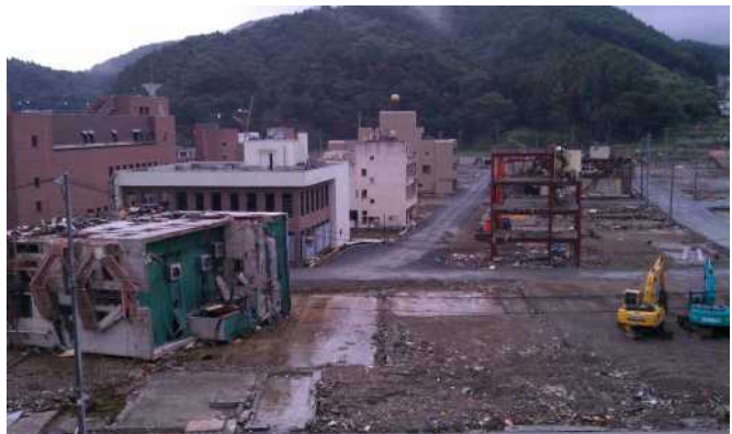
女川病院から見た被災した街並み
